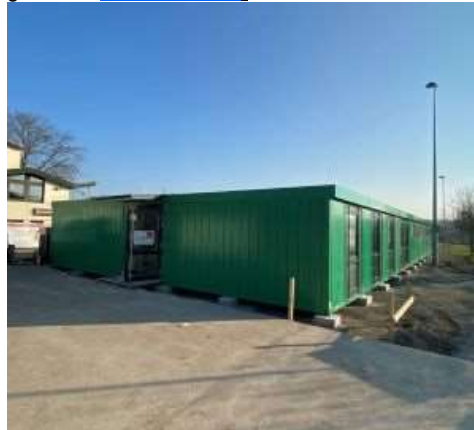
Foto: Stadt Remseck: Aus der Bauphase Sicherer Schulweg
