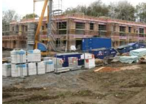
Foto: FDP: aktueller Bautenstand April 2023 InterimsKita „Im Pfädle“
